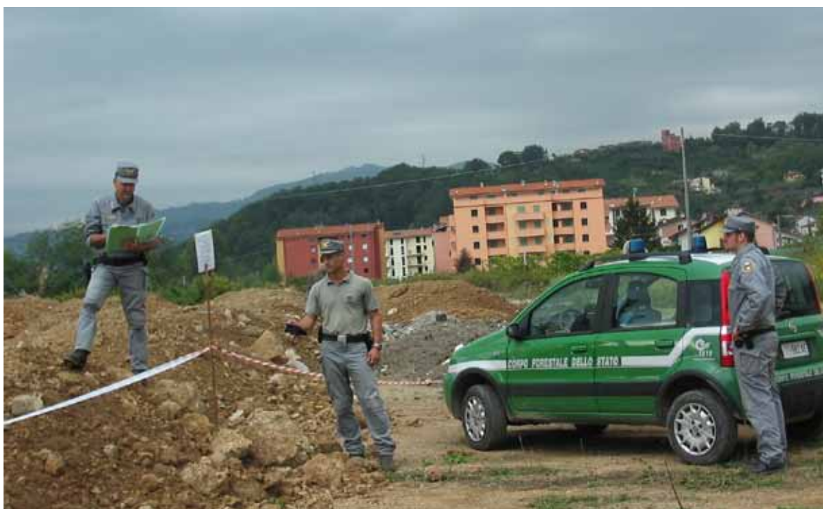
Massa Carrara - Tutela del territorio in ambito urbanizzato contro le illegali costruzioni e smaltimenti di terra e rocce da scavo.
